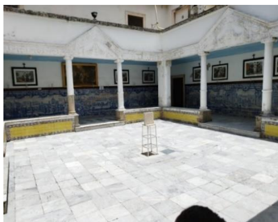
Figura 30 - Pátio do Edifício
