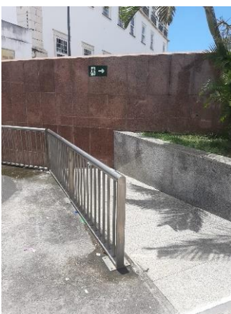
Figura 25 - Ausência de sinalização para rampa na Praça da Cruz Caída
