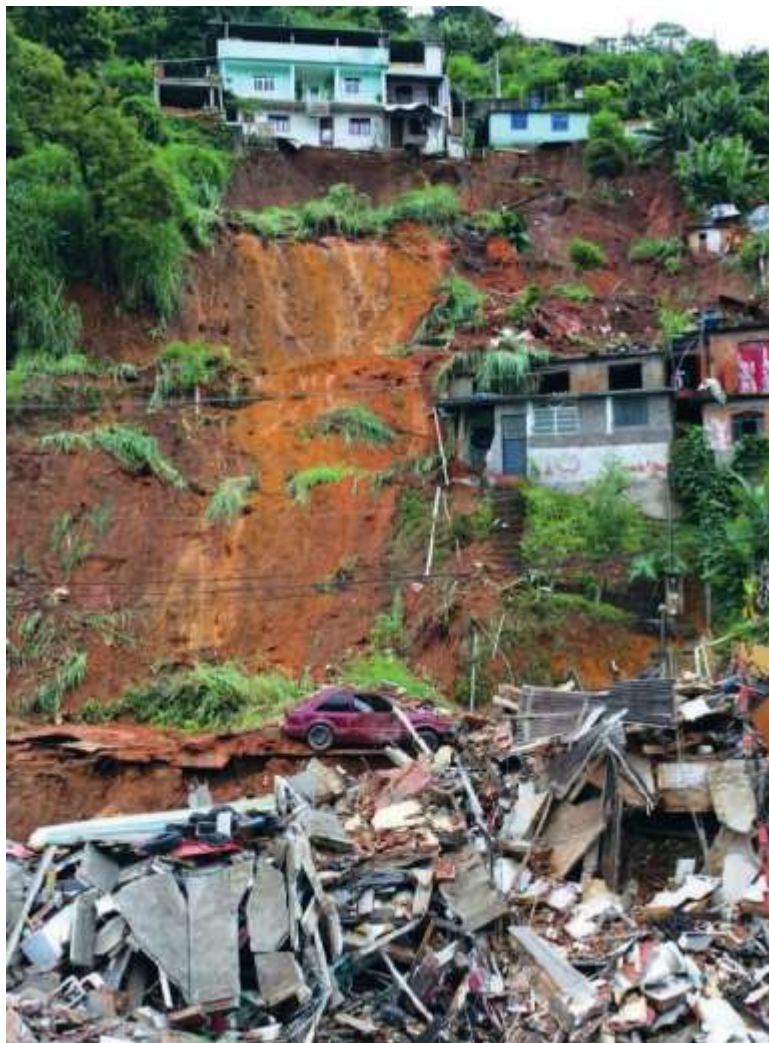
Figura 52 – Deslizamento de terra em Nova Friburgo (RJ) – 2011
