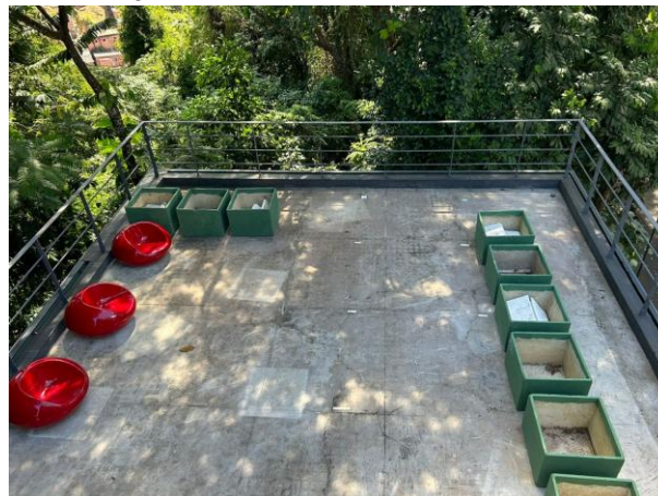
Figura 30 – Cobertura do primeiro andar do prédio do Jardim Botânico de Salvador-BA.
