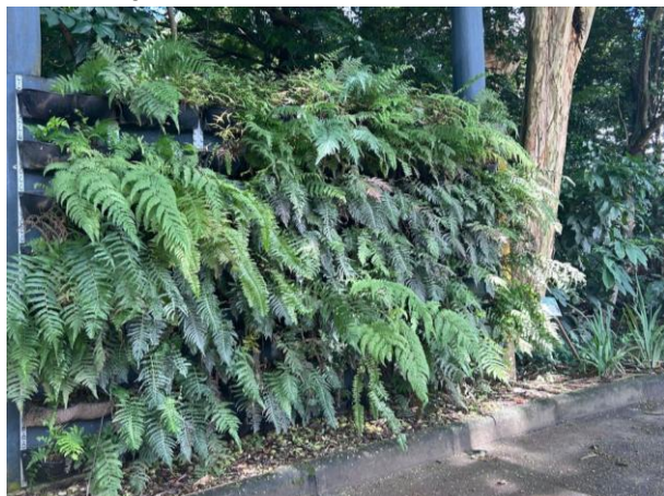
Figura 25 – Fachada vegetal na guarita de acesso ao Jardim Botânico de Salvador-BA.
