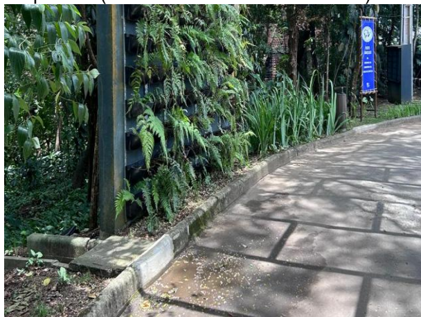
Figura 47 – Pontos de escoamento das águas pluviais (em funcionamento e interditado).
