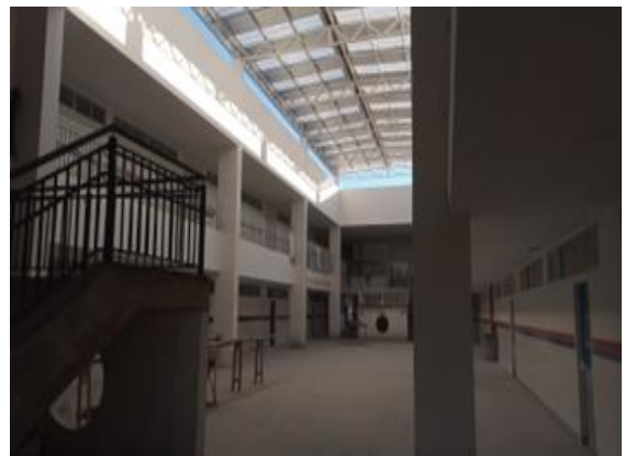
Após ampliação e em fase de conclusão
