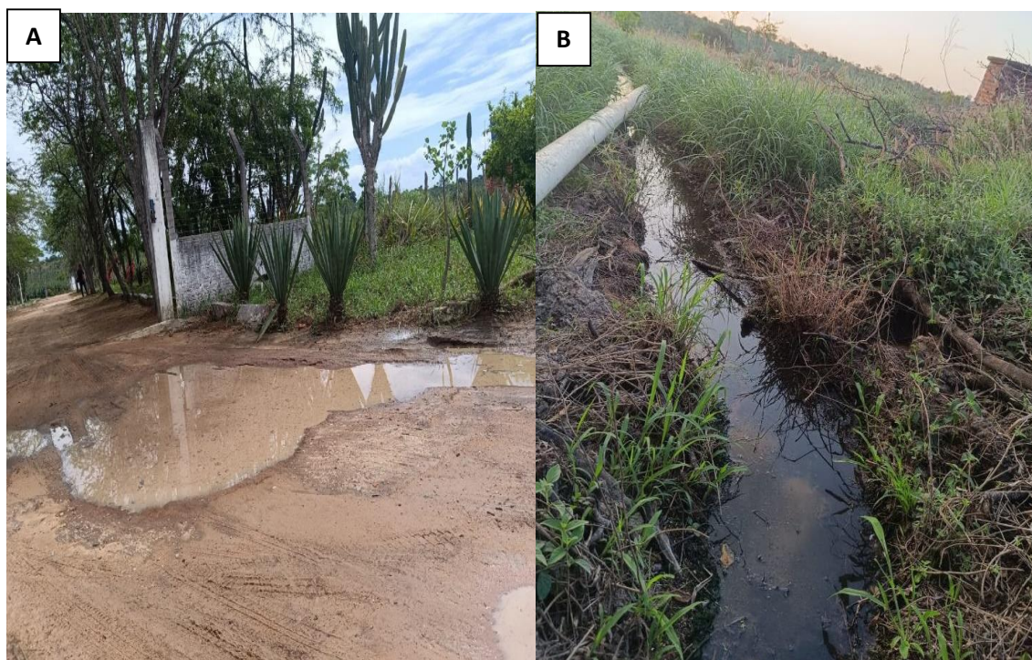
Figura 1: Diagnóstico inicial do manejo inadequado de águas cinzas no CAECDT.
