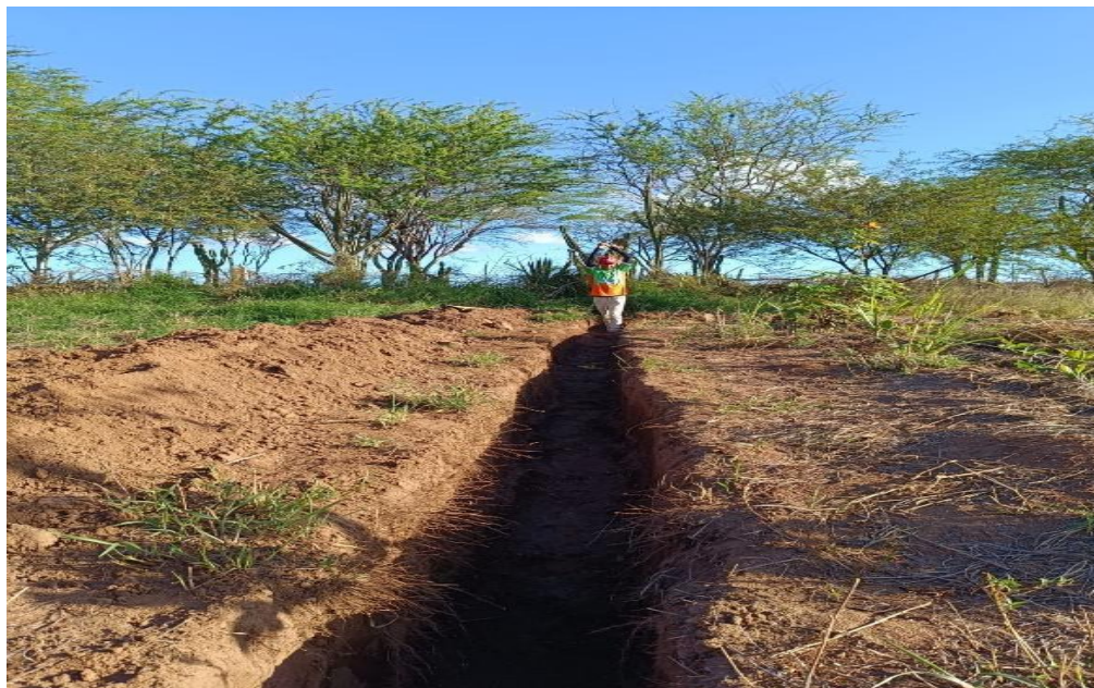
Figura 3: Escavação da valeta para condução das águas cinzas.
