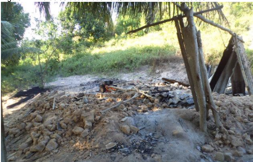
Figura 21: Moradias destruídas no Quilombo Rio dos Macacos
