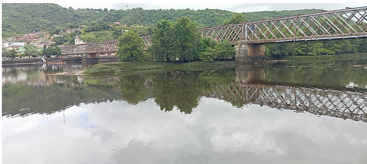
Figura 17 - Ponte D. Pedro II e rio Paraguaçu
