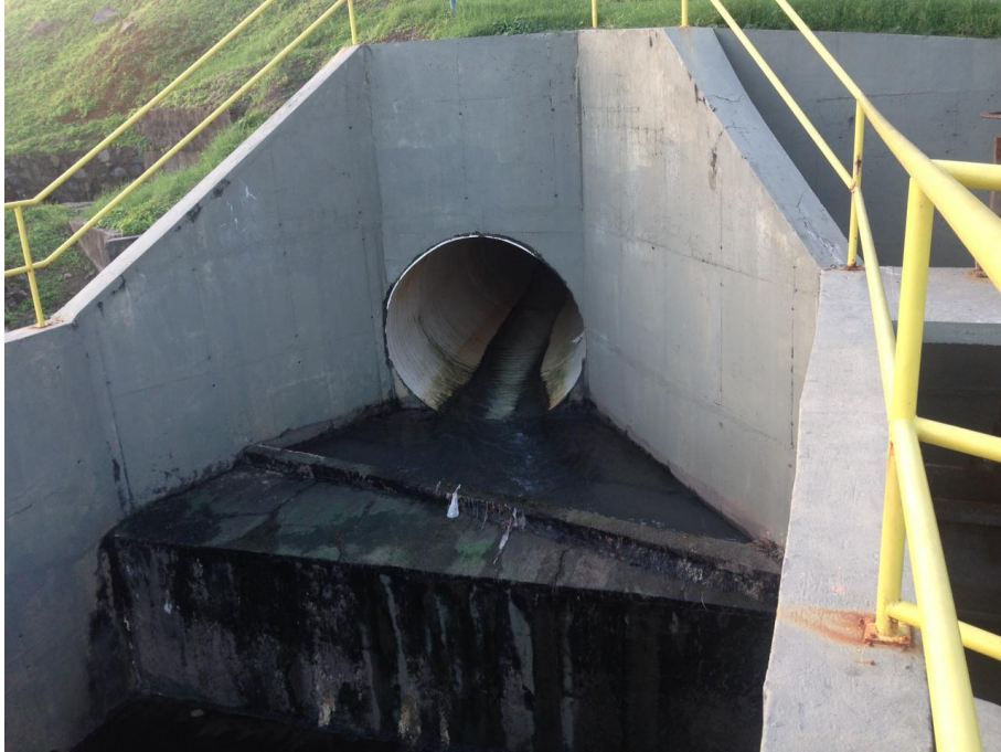
Figura 41: Foz canalizada do rio dos Seixos e desvio em forma de batente Fonte: Autoria própria (2021).
