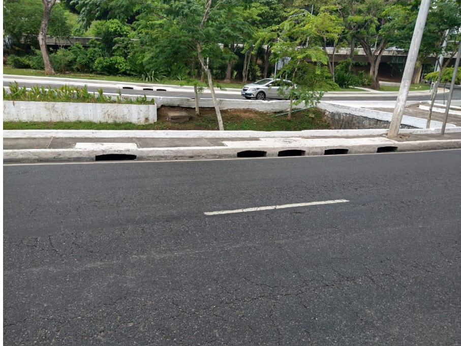
Figura 38: Bocas de lobo no rio dos Seixos Fonte: Autoria própria (2021).
