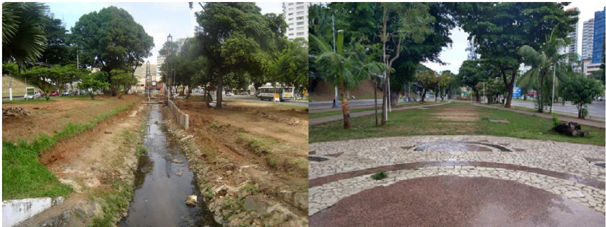
Figura 8: Curso em tamponamento do rio dos Seixos/ Curso tamponado do rio dos Seixos Fonte: SILVA FILHO (2008) e Autoria própria (2021).
