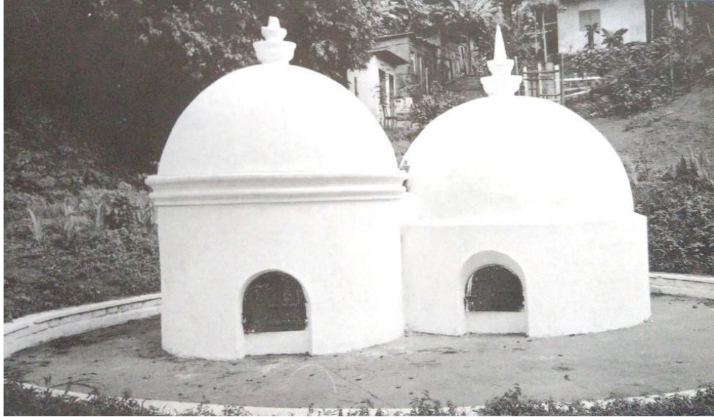
Figura 27: Fontes no Dique do Tororó Fonte: EMBASA (2006).
