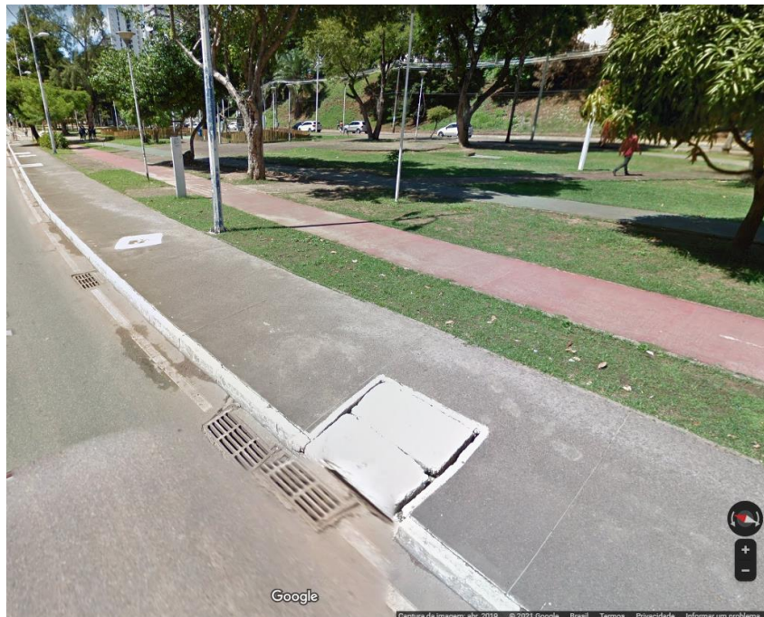
Figura 39: Canal tamponado do rio dos Seixos funcionando como canal subterrâneo de escoamento Fonte: Google Street View (2021).
