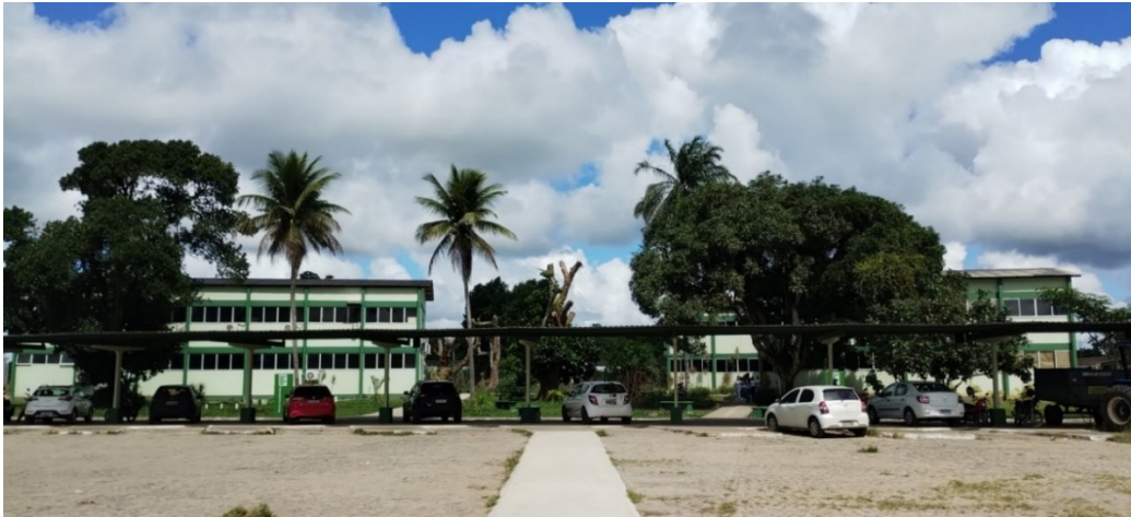
Figura 22 – Pavilhão acadêmico à esquerda e pavilhão aulas à direita
