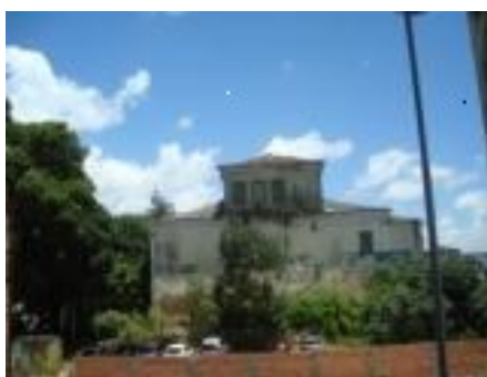
Foto 3: LATERAL DO ANTIGO PRÉDIO DO COLÉGIO SEVERINO VIEIRA, 2010 Fonte: SOUZA, 2010
