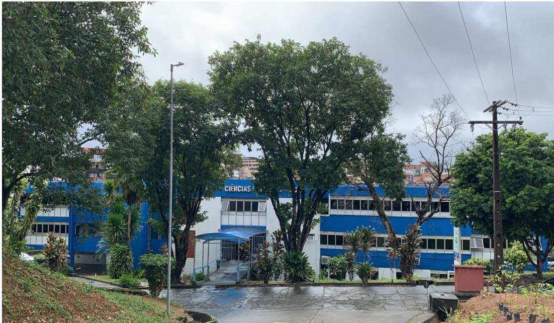
Figura 4 - Fachada principal do prédio do DCH I
