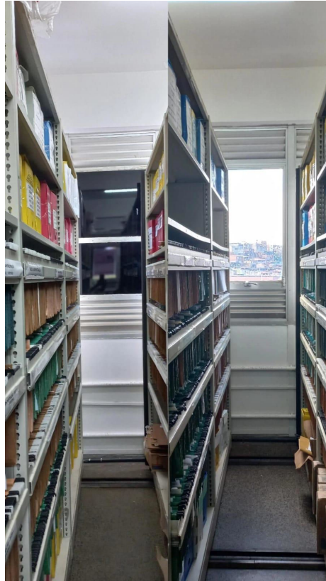
Figura 9 - Janelas com e sem película de proteção solar
