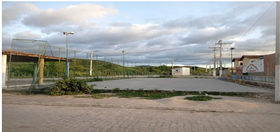
Figura 4 - Quadra esportiva e parque infantil do bairro destruídos
