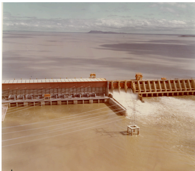
Figura 3 - Casa de máquinas e extravasores da barragem e hidrelétrica de Sobradinho. 1983.
