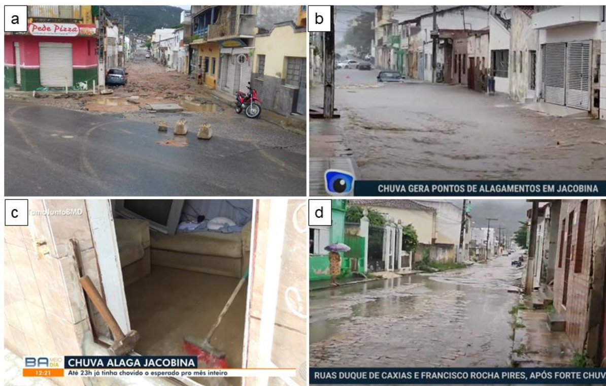
Figura 46 - a) Inundação na Rua Duque de Caxias: dezembro de 2018; b) Inundação na Rua Duque de Caxias: janeiro de 2020; c) Casa inundada pelo extravasamento do Canal Duque de Caxias – Lomanto Júnior: dezembro de 2022; d) Rua Duque de Caxias após evento extremo: fevereiro de 2024.
