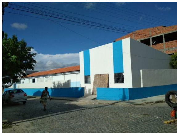
(ii) Construção da creche e Unidade de pronto atendimento
