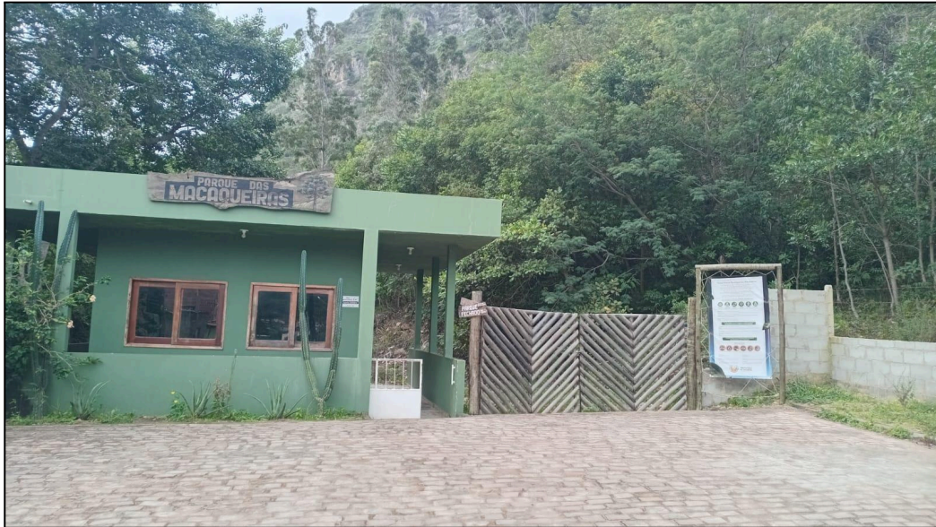
Figura 4 - Equipamento (guarita) de acesso ao parque
