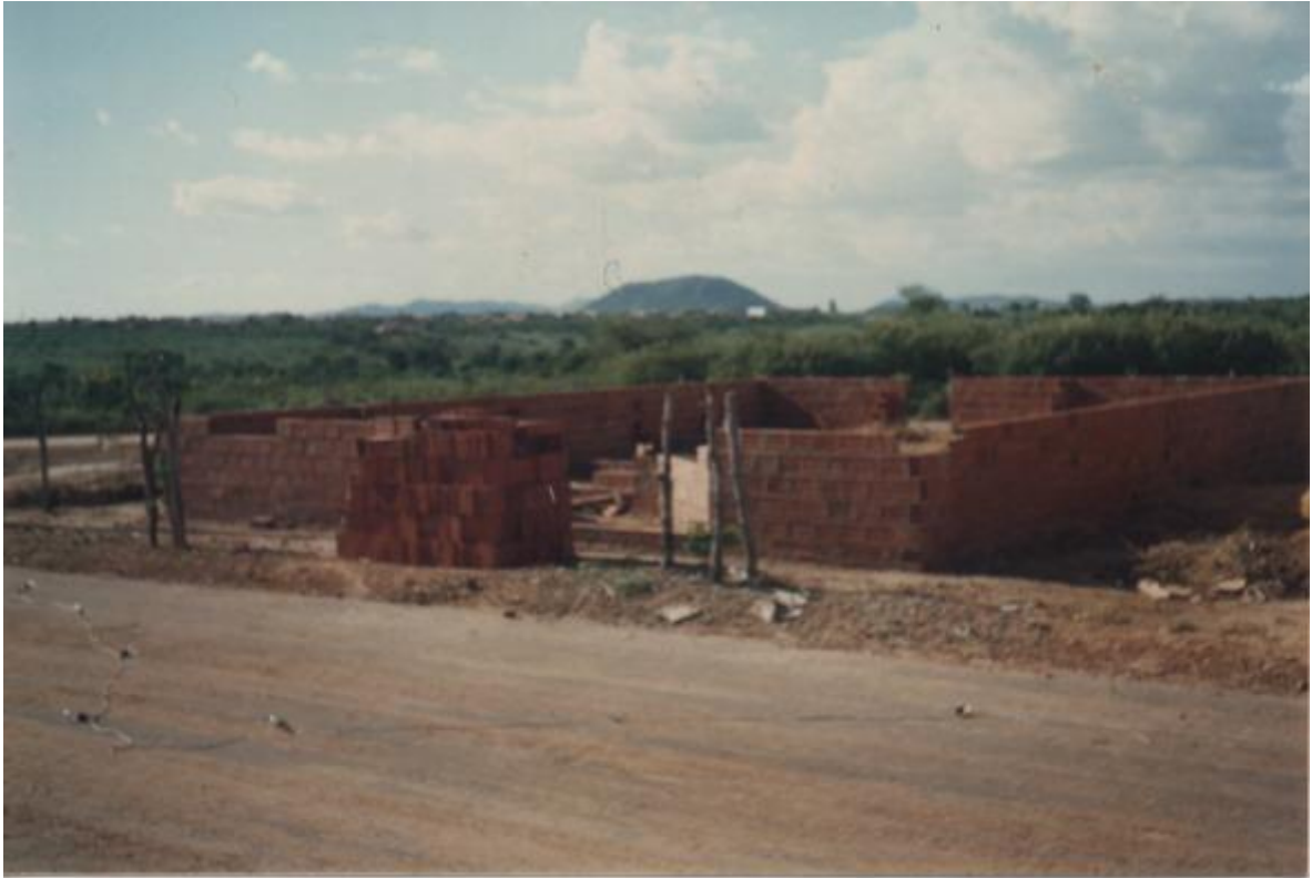
Figura 9. Construção da sede
