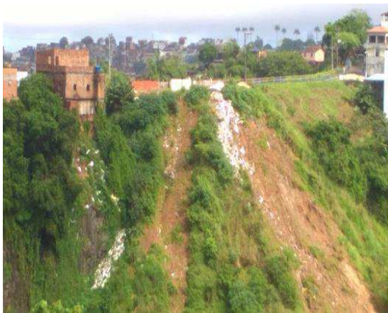
Foto 3 – Desgaste provocado pelo acúmulo de resíduos sólidos.
