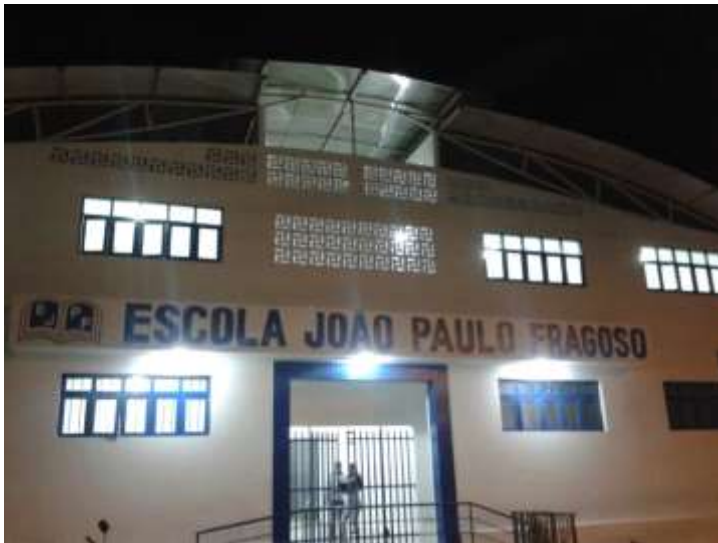
Figura 2. Fachada da Escola Municipal João Paulo Fragoso
