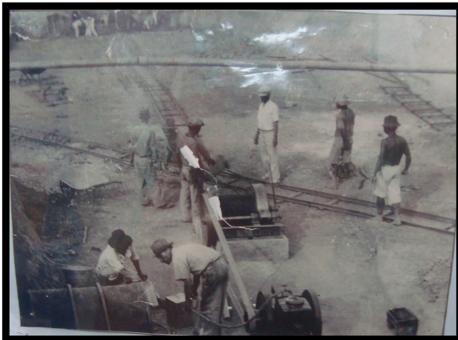
Foto 6: Homens trabalhando na construção do Açude Federal.
