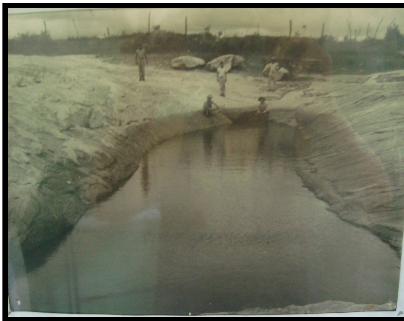
Foto 7: Açude Federal Ouro Verde em construção Fonte: Arquivo da Biblioteca Municipal
