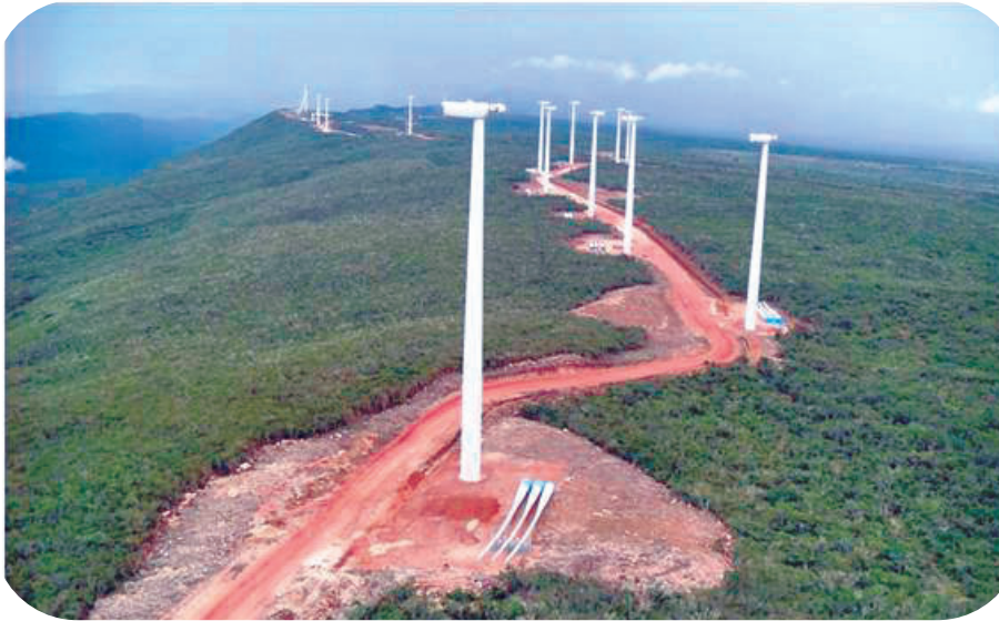
Instalação de Torre Eólica em Lages do Batata
