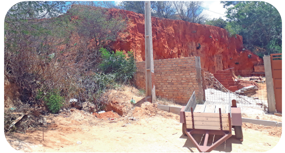
Área com cortes em talude e retirada de blocos rochosos
