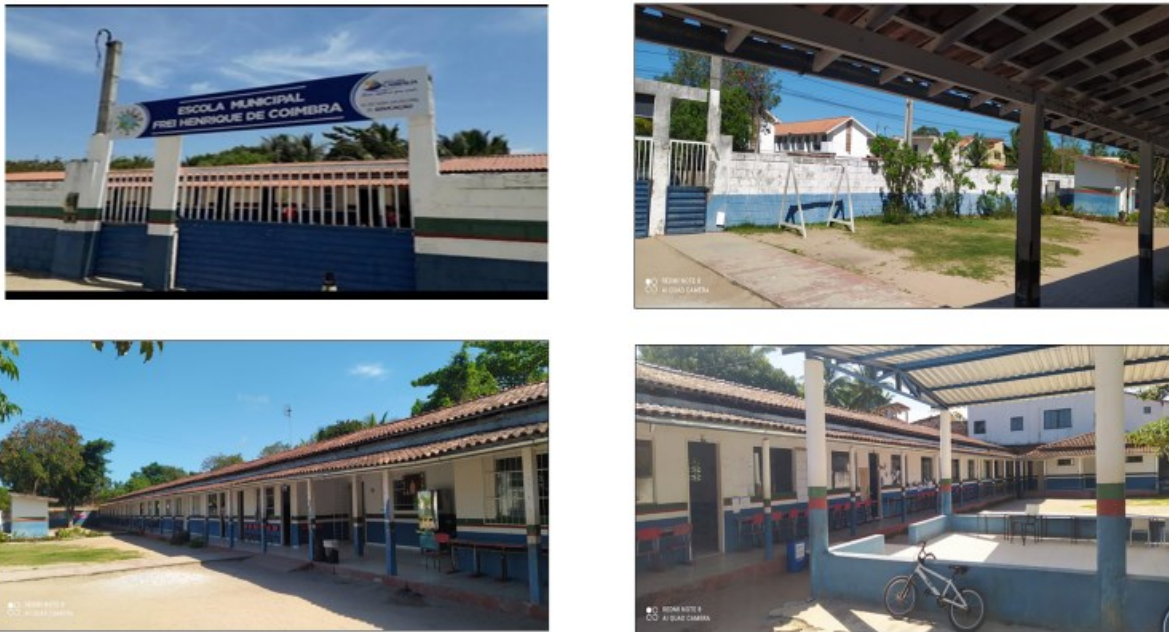
Figura 8 — Fachada e pátio da Escola Frei Henrique Coimbra.
