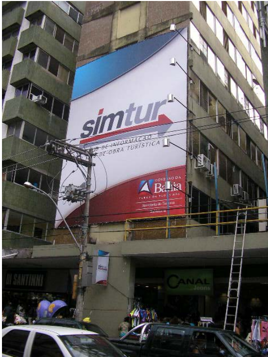
Foto 28: Empena-cega da SIMTUR instalada de frente para a Avenida Sete de Setembro (2008). Fonte: Acervo da autora.
