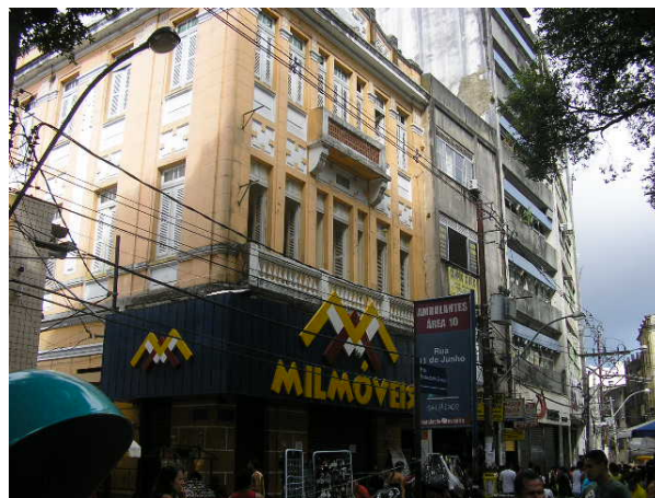
Foto 15: Fiação aérea na Rua 11 de Junho, Largo de São Pedro (2008). Fonte: Acervo da autora.
