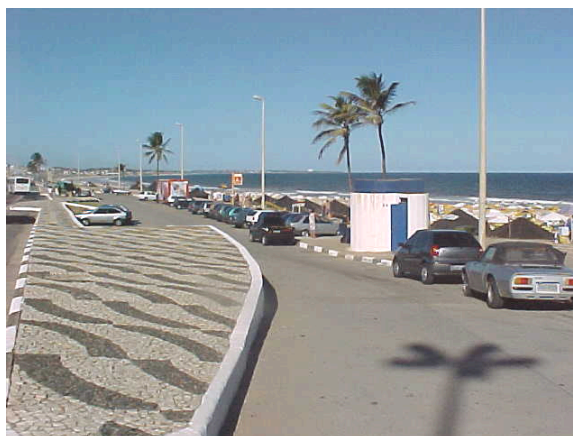
Figura 4 – Sanitário Público Padrão Desal
