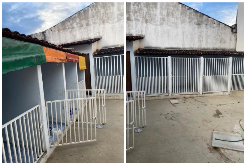
Figura nº9: área externa de hospedagem.
