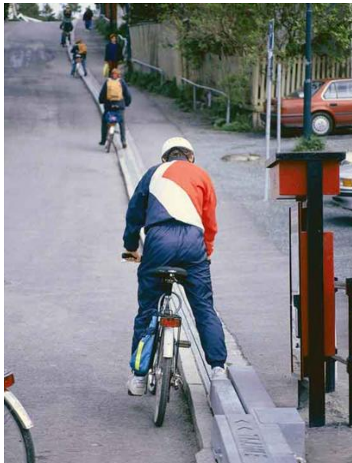
FIGURA 47 - Sistema Trampe: elevador de bicicletas.
