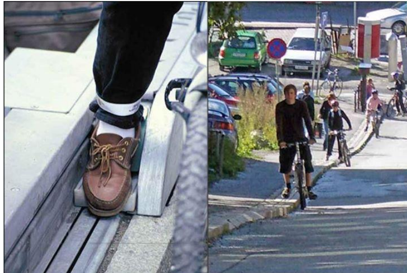
FIGURA 46 – Sistema Trampe: elevador de bicicletas instalado em Belo Horizonte,
