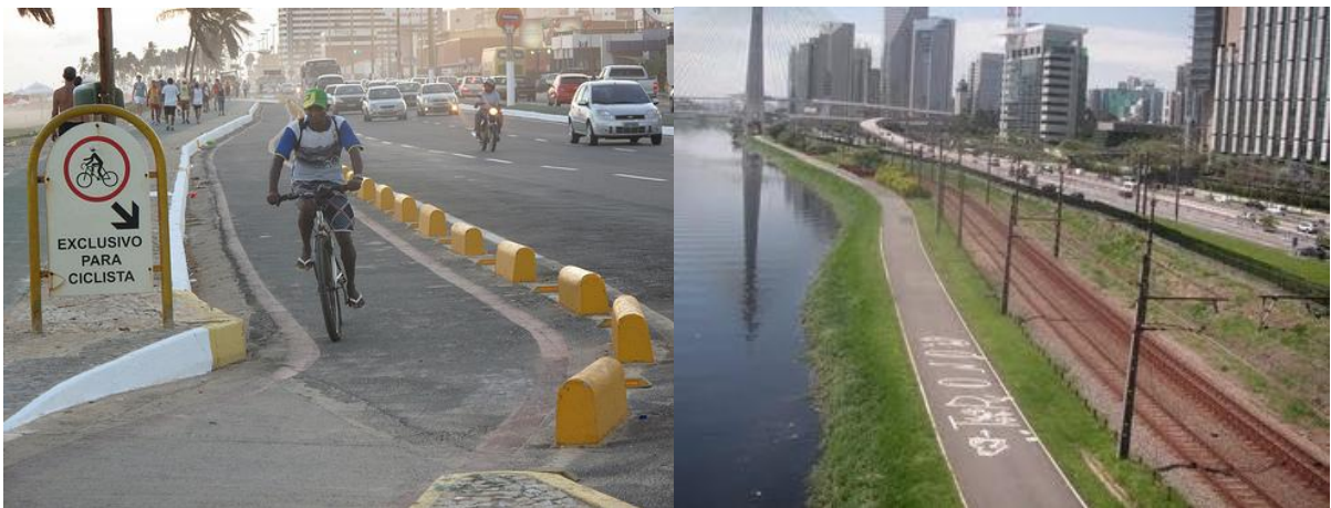
FIGURA 19 – Ciclovía na pista de rolamento da orla de Salvador (esquerda). Ciclovía às margens do rio na Av. Marginal Pinheiro em São Paulo.
