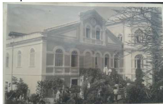
FIGURA 19: Vista frontal da sede do CAV da rua Coqueiro da Piedade
