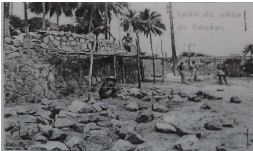
FIGURA 100: Lateral da sede do CRPE – Bahia
