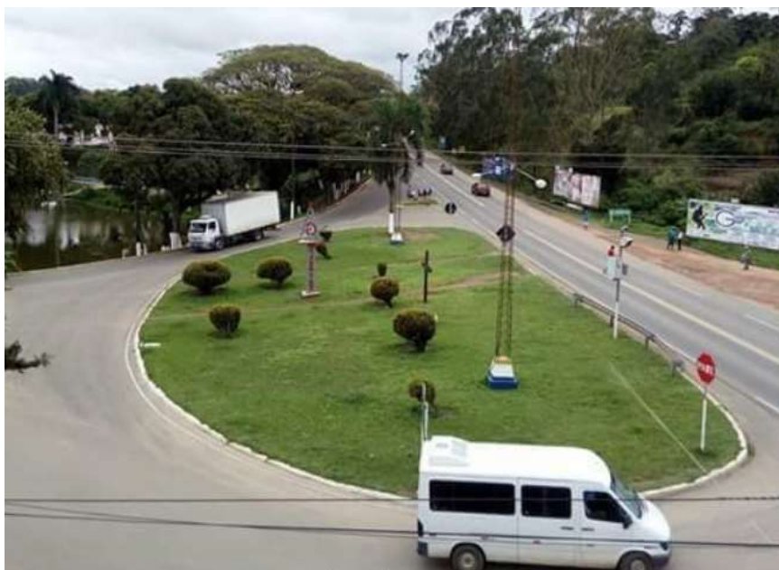
Figura 7 - Gandu: Conexão com a Rodovia BR – 101
