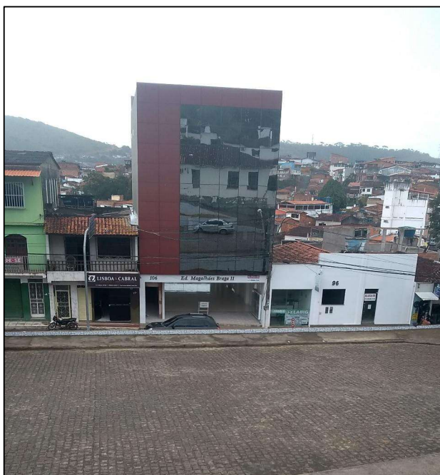
Figura 14 - Gandu : Edifício Verticalizado no Centro da Cidade.
