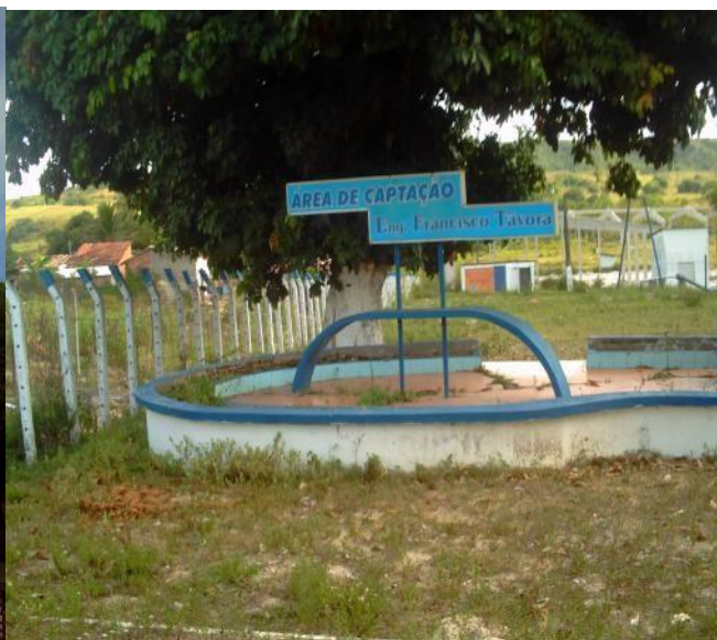
Fotos 2, 3 e 4 SAAE Área de Captação em Sobocó
