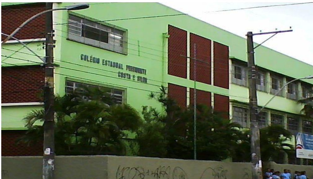
Figura 2: Fachada do colégio
