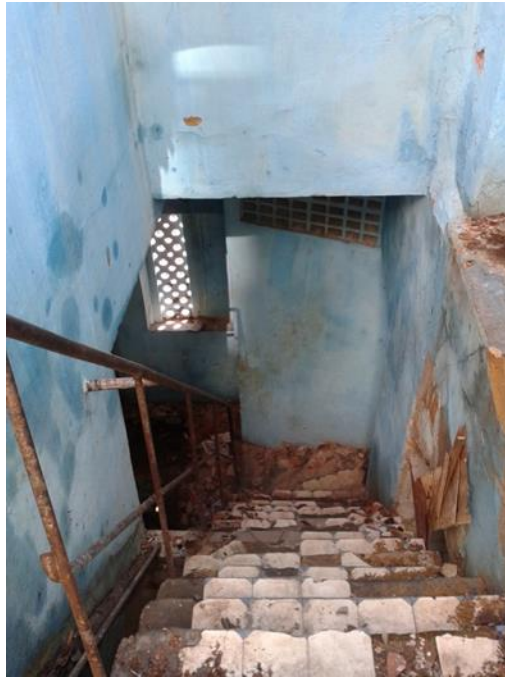
Figura 12: Escadas do Bar 73.
