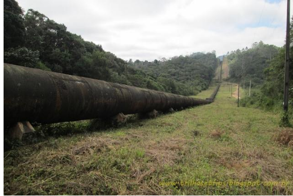
Imagem 76 — Adutora Rio Claro, Capela do Ribeirão, século XXI
