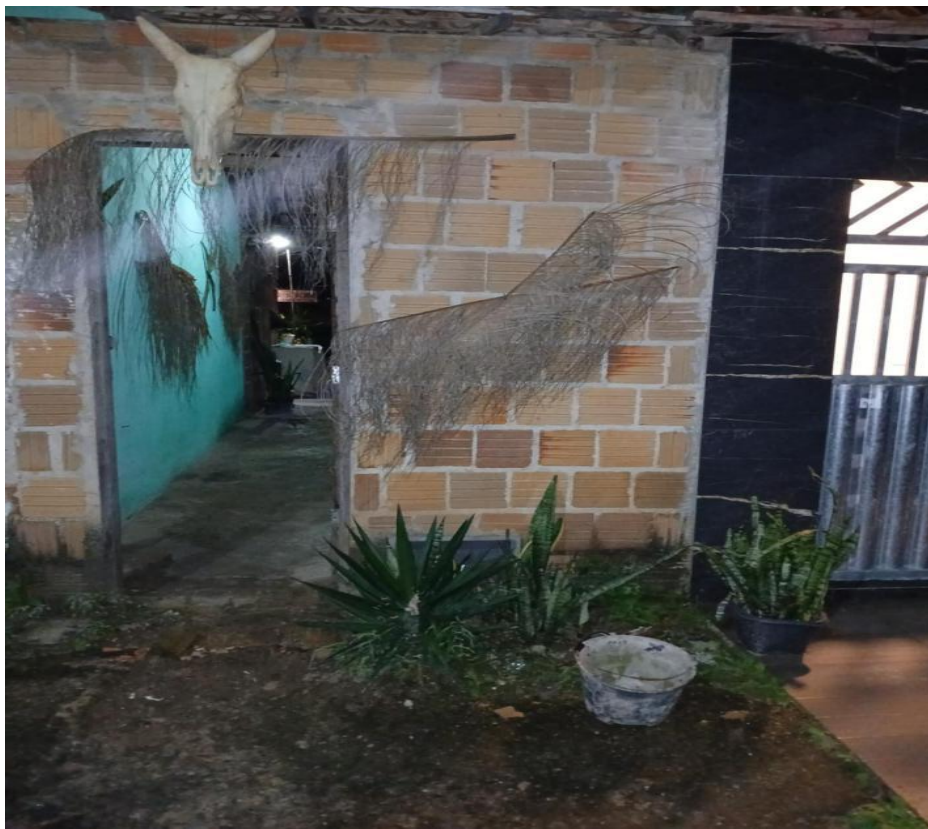
Figura 1- Fachada do Terreiro Rainha Do Mar
