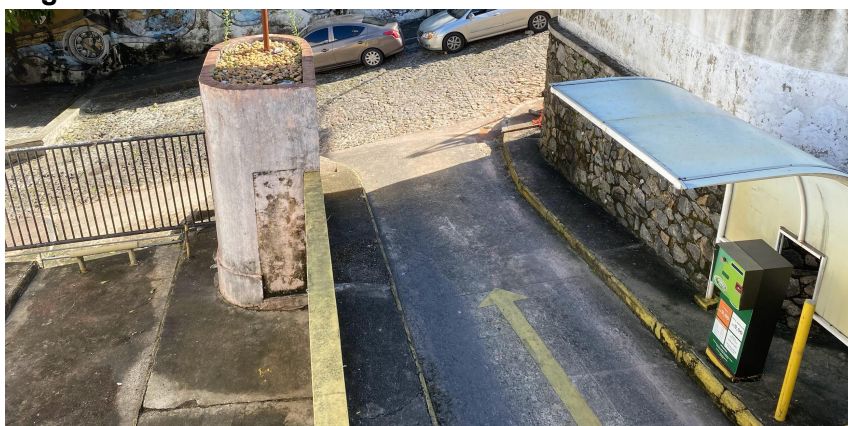
Figura 45 – Estacionamento Bahia Park
