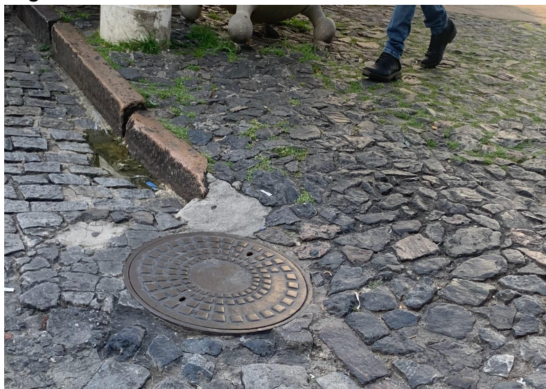
Figura 12 – Barreira Urbanística Bueiro
