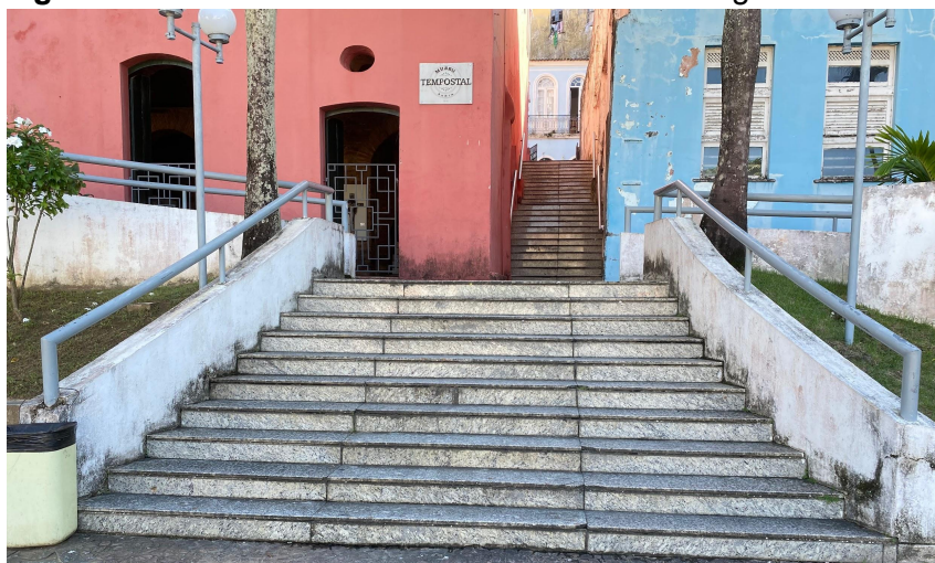
Figura 48 – Escadarias de acesso ao Delta Parking
