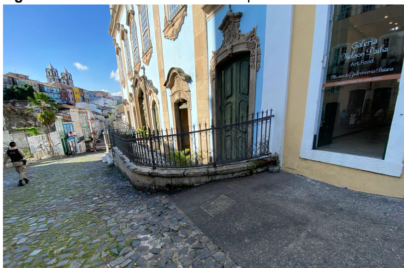
Figura 33 – Barreira Urbanística Rampa de acesso
