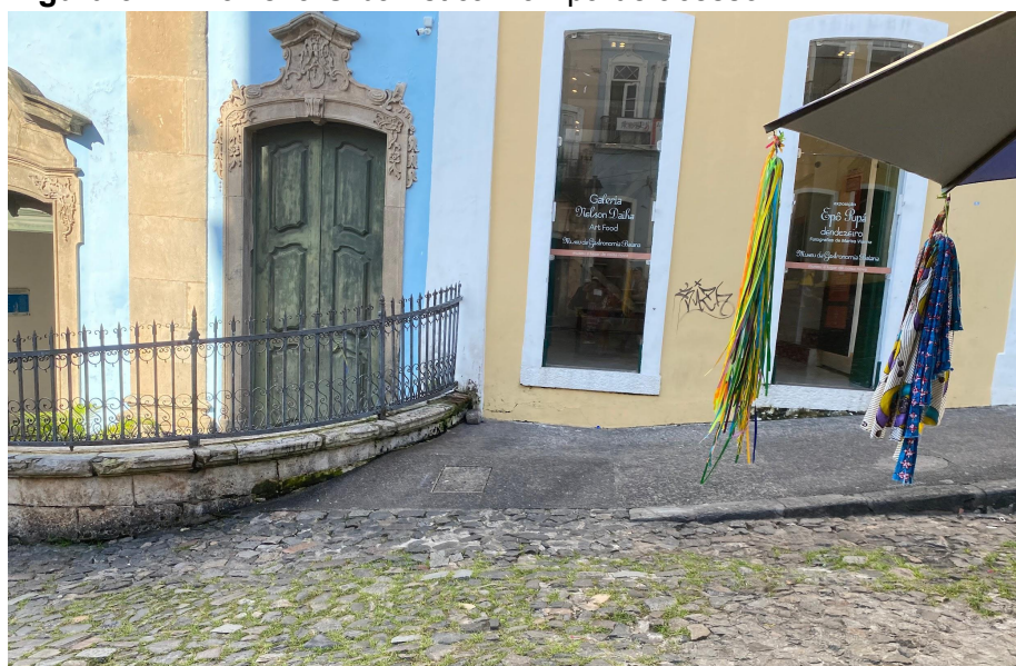
Figura 32 – Barreira Urbanística Rampa de acesso
