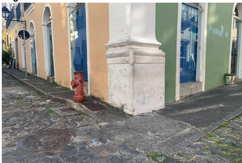
Figura 16 – Barreira Urbanística Hidrante
