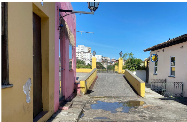
Figura 46 – Rampa de acesso superior do estacionamento Bahia Park
