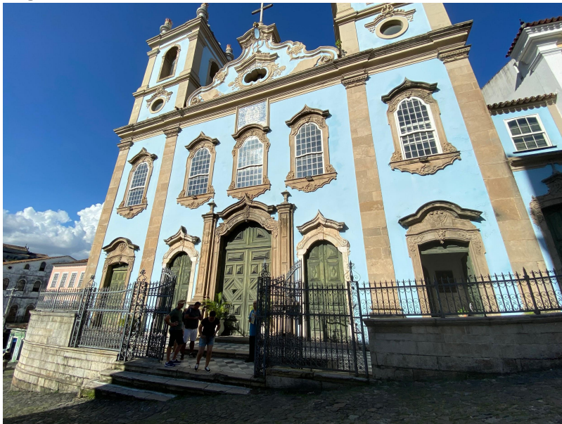
Figura 34 – Barreira Arquitetônica escadaria
