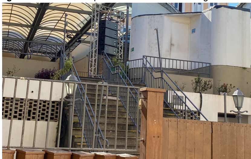
Figura 39 – Barreira Arquitetônica Escadaria do Largo Tereza Batista
