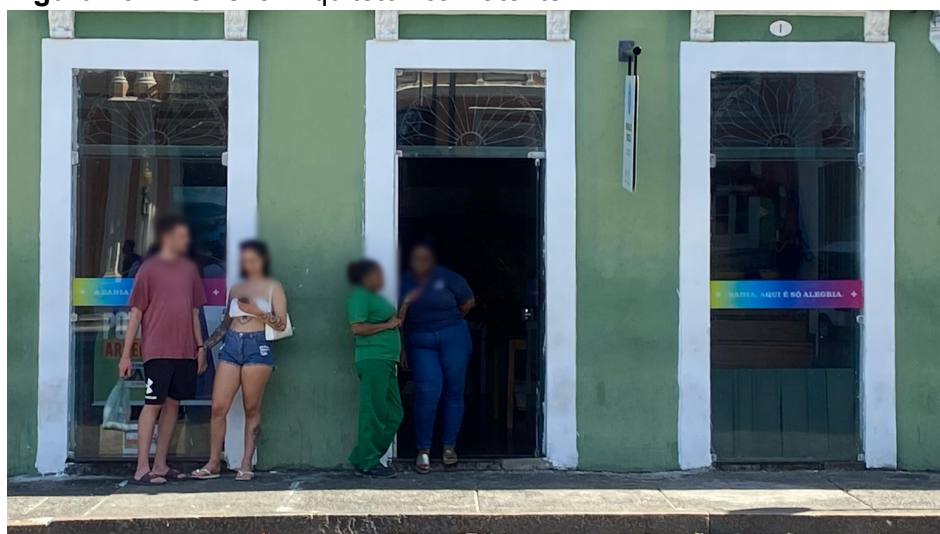
Figura 29 – Barreira Arquitetônica Batente
