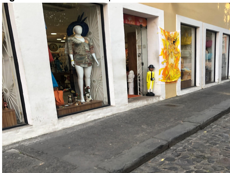
Figura 21 – Barreira Arquitetônica Batente
