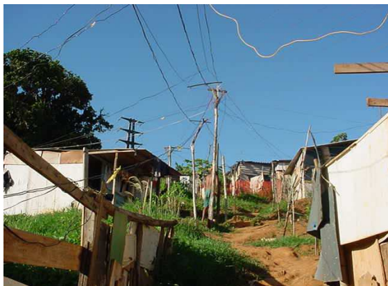
Foto 14: Vista dos barracos na ocupação do Metrô. (SEHAB, 2005)
