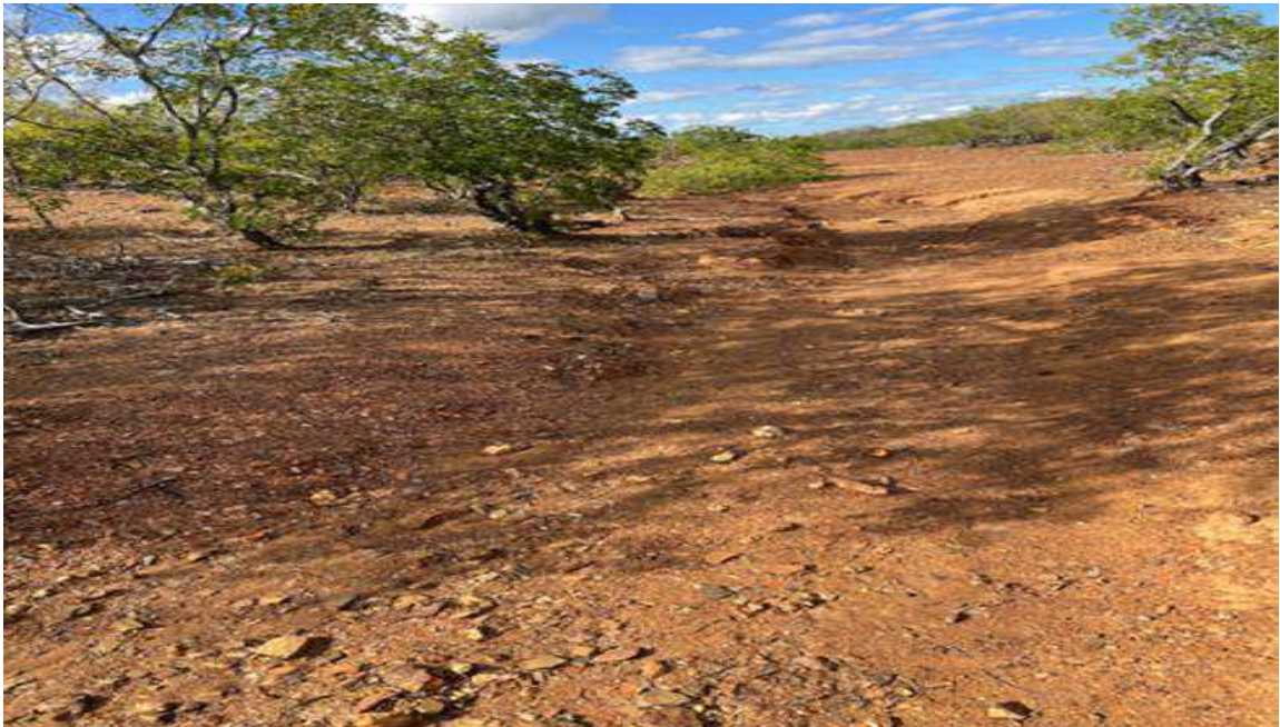
Fotografia 30 - Manutenção deficiente de vias e acessos no interior do Parque Estadual de Canudos, Bahia (BR)
