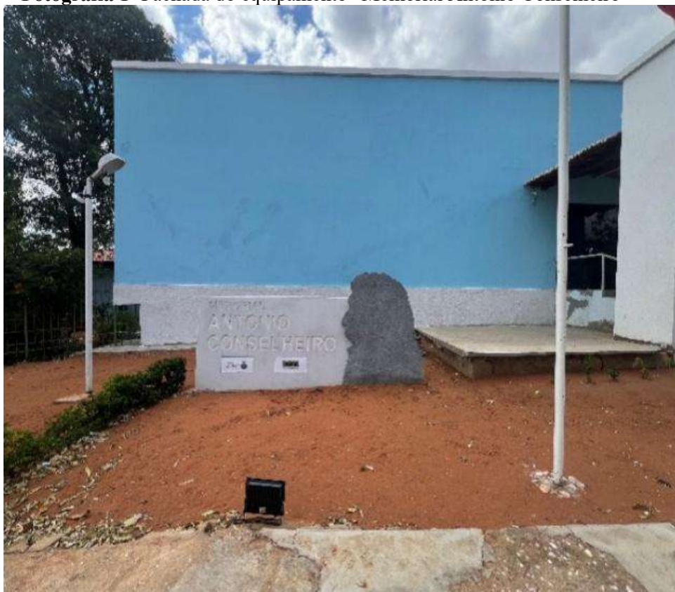
Fotografia 1- Fachada do equipamento “Memorial Antônio Conselheiro”
