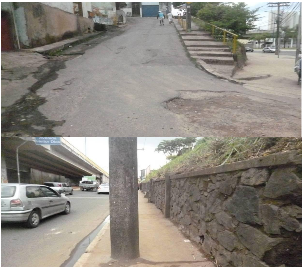
Figura 31- Ladeira extensa e Poste no passeio
