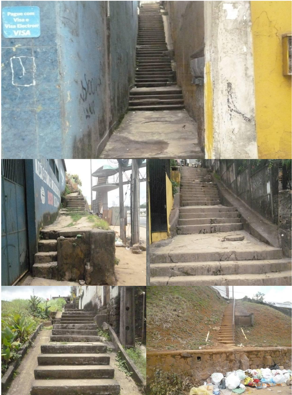
Figura 30- Escadarias com inclinação elevada
