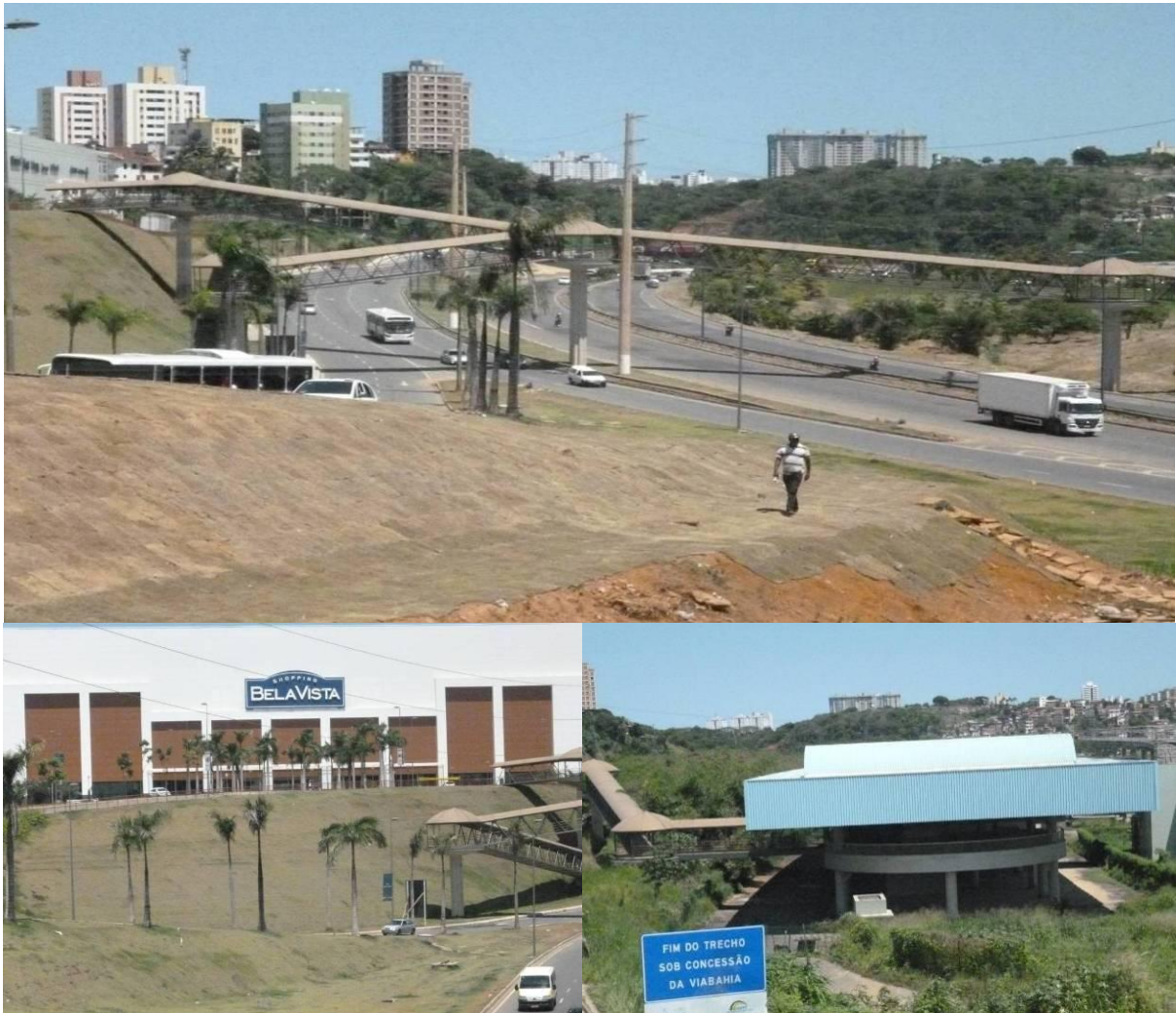
Figura 04- Passarela ligando o HBV à Estação Metroviária Acesso Norte
