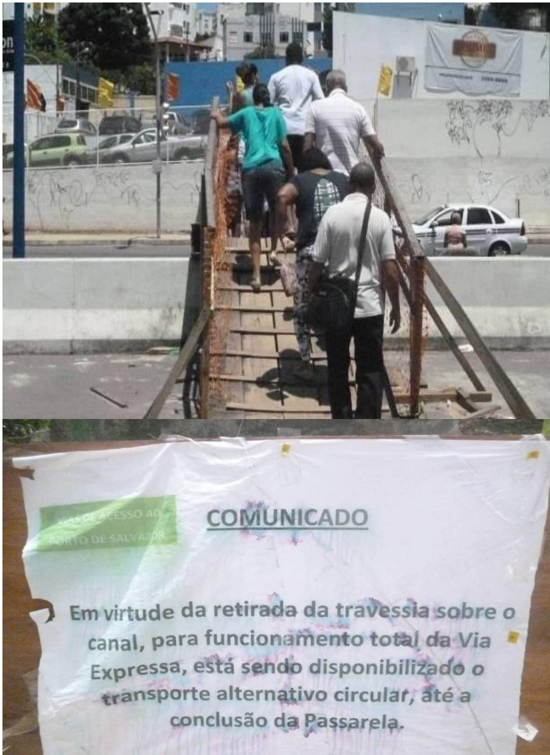
Figura 43- Ponte improvisada que foi retirada
