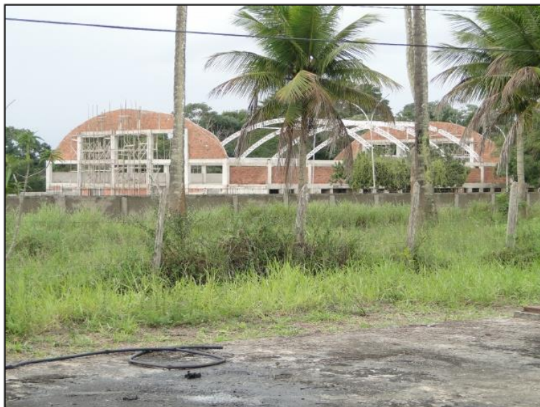
Figura 7 – Construção em andamento do IFBA – SAJ
