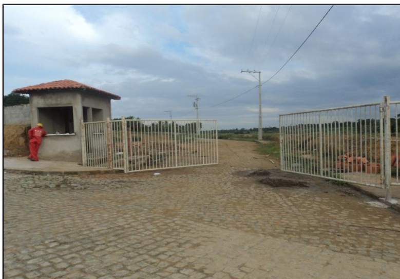
Figura 9 - Condomínio em construção no bairro Cajueiro
