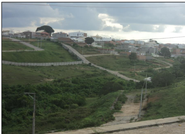
Figura 10 - Grande condomínio construído no bairro Cajueiro
