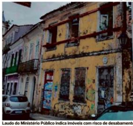
Lauda do Ministério Público indica imóveis com risco de desabamento
