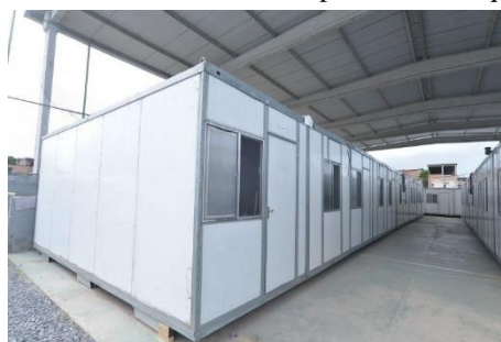
Figura 13: contêineres instalados de forma provisória na quadra poliesportiva.
