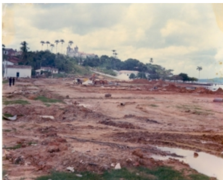
Fonte: Prefeitura de São Francisco do Conde Figura 14 – Aterro e construção do Parque Duque de Caxias.
