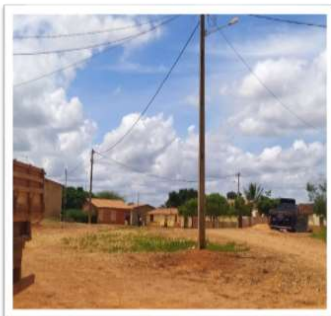
Figura 39 – Área beneficiada com as unidades habitacionais.
