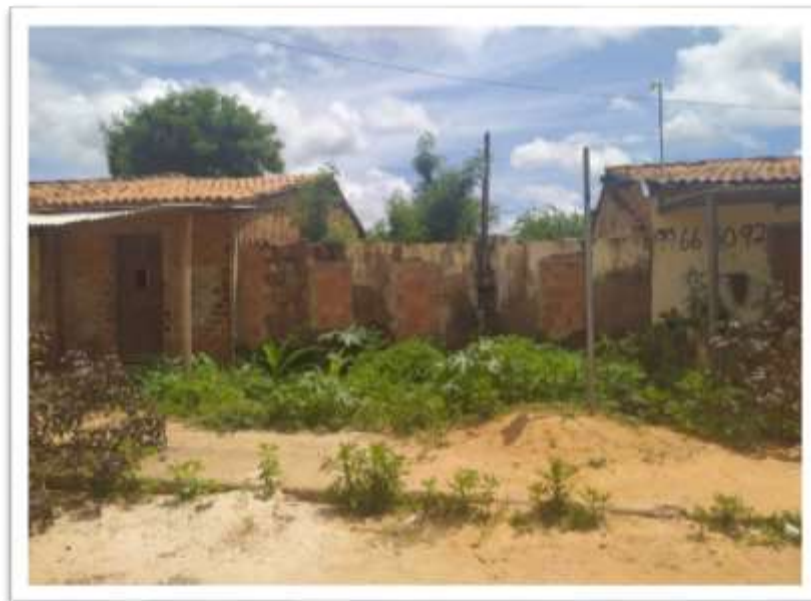
Figura 13 – Fotografia da casa em ruínas de Osório José Alves.
