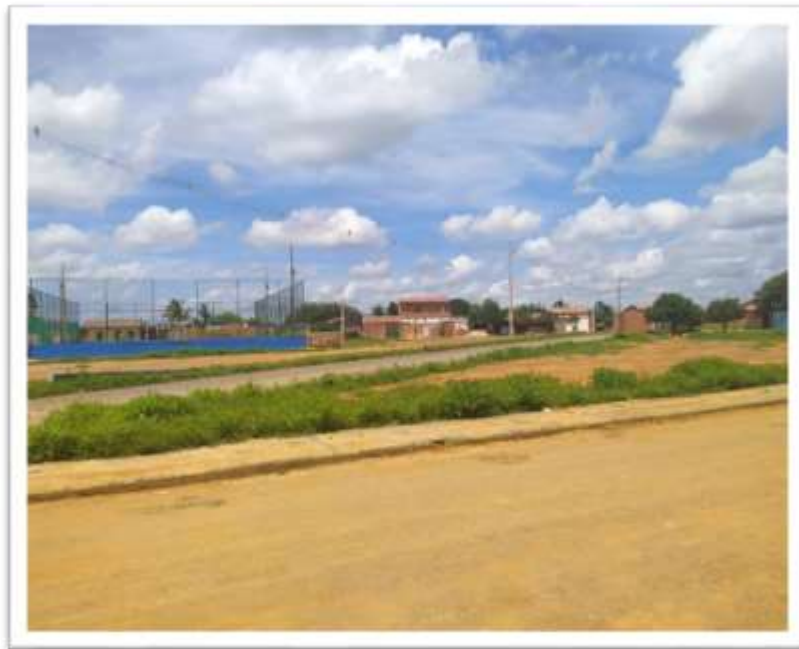
Figura 07 – Fotografia da praça central, em Lagoa do Gaudêncio.
