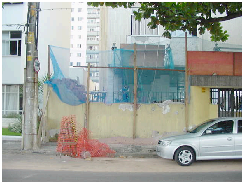
Obras nos prédios impedem a passagem dos pedestres pelas calçadas.
