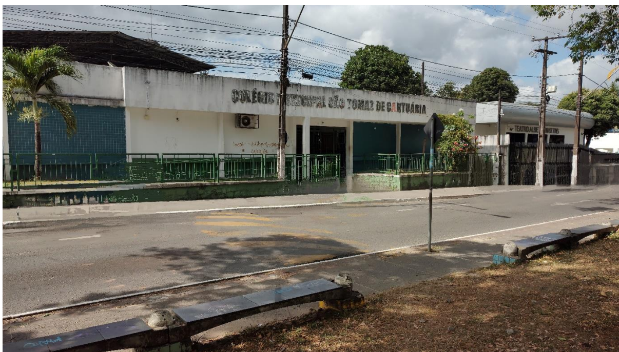
Foto 1: Fachada do Colégio Municipal São Tomaz de Cantuária
