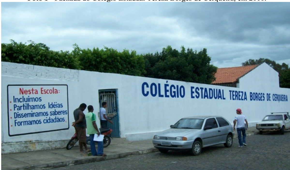
Foto 1 - Fachada do Colégio Estadual Tereza Borges de Cerqueira, em 2010.
