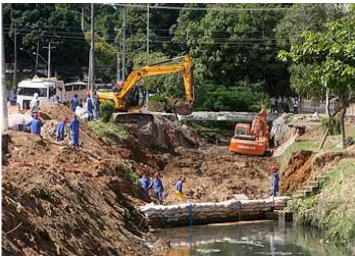
FIGURA 29 - Obras de macrodrenagem no rio Lucaia. Fonte: A TARDE, 2011.
