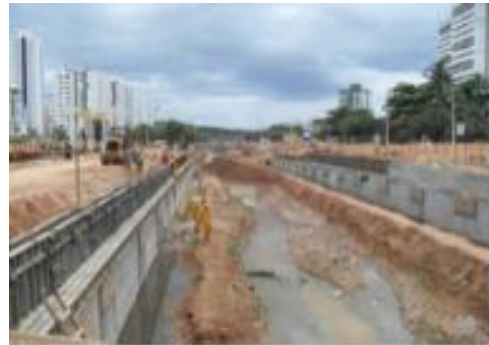
FIGURA 24 - Rio Cascão quando ocorria a implantação das galerias de concreto. Fonte: SALVADOR, 2009.
