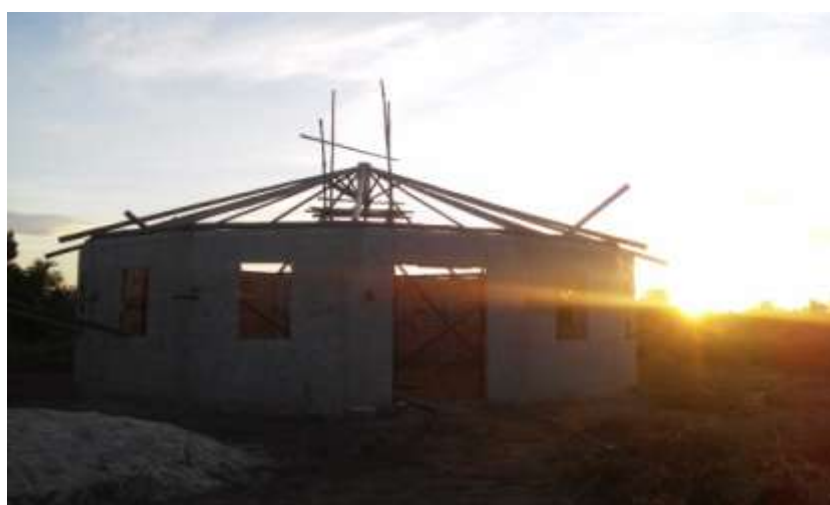
Fotografia 32- Construção de nova sede da Igreja Assembleia de Deus
