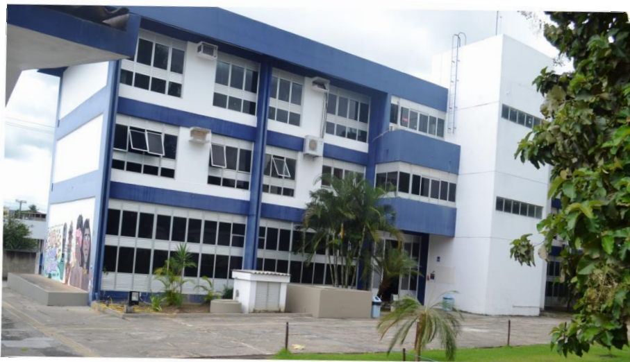
Figura 03 - Pavilhão de aulas Professora Norma Neyde Queiroz de Moraes
