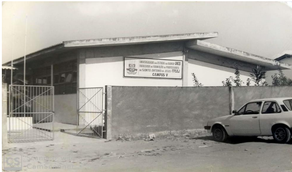
Figura 02 - Pavilhão de aulas Professor Alvacir Brito Barbosa
