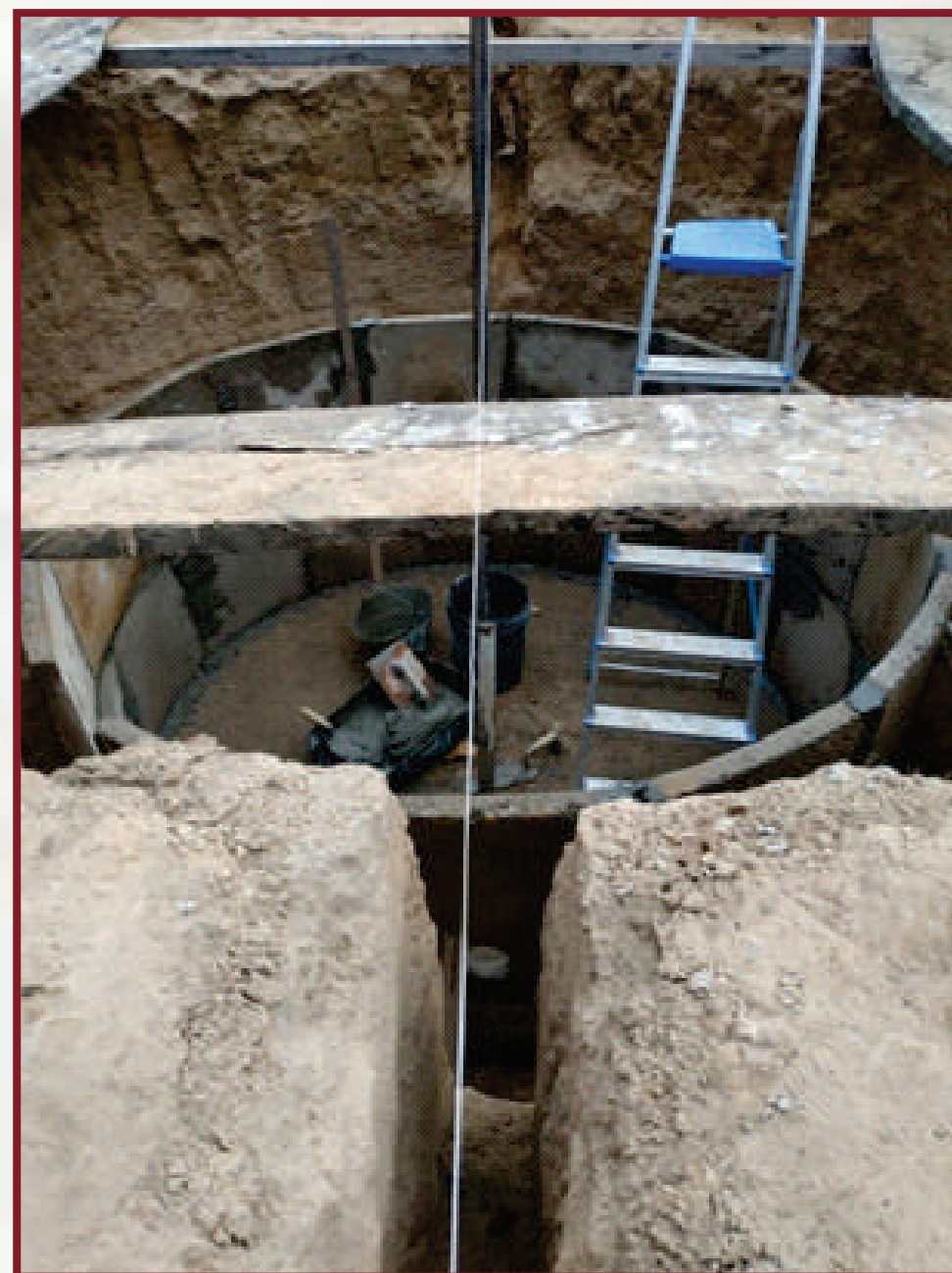
Figura 24 - Aprumação da placa com o buraco de entrada do dejetto
