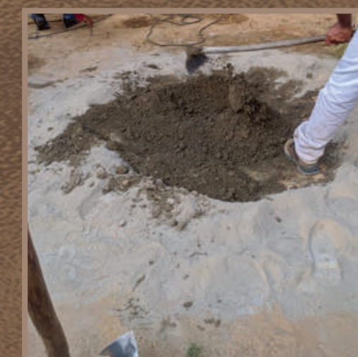
Figura 14 - Preparação da massa das placas
