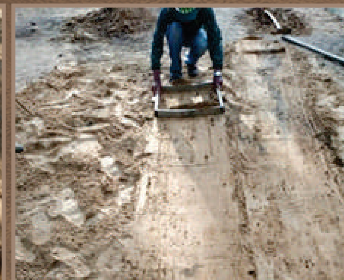
Figura 13 - Preparação do solo para a confecção das placas de cimento
