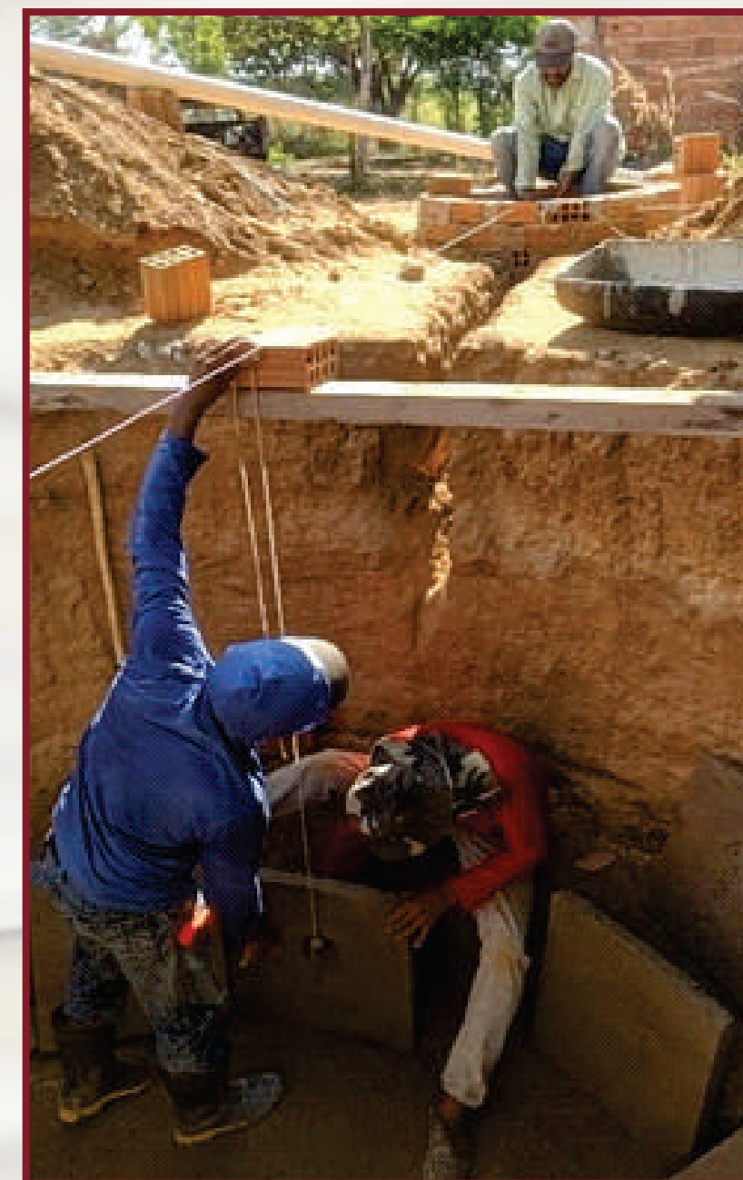
Figura 25 - alinhamento do buraco de saída do biofertilizante com a caixa de saída.
