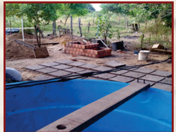
Figura 19 - madeira parafusada na extremidade da caixa
