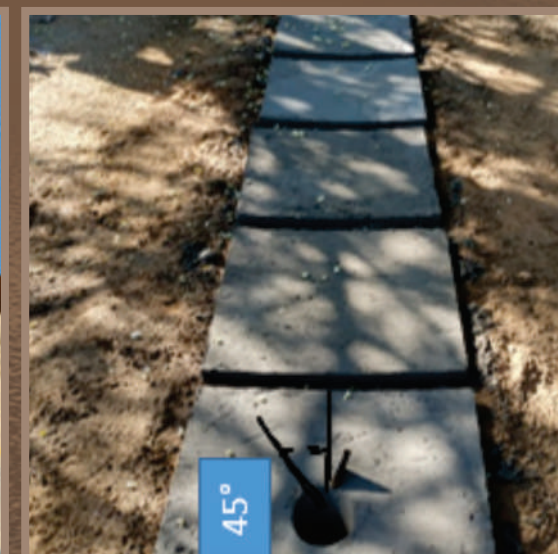
Figura 15 - Placas prontas para serem assentadas, detalhe para o buraco em 45° na primeira
