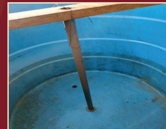
Figura 23 - marcação do local onde serão assentadas as placas de cimento
