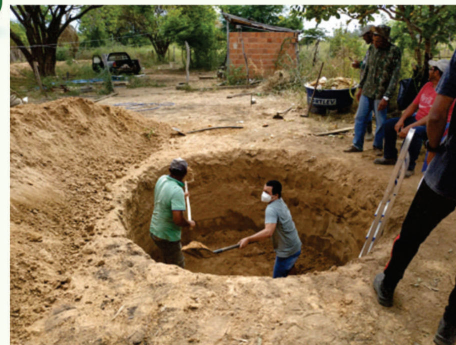
Figura 9 - Início da abertura dos buracos
