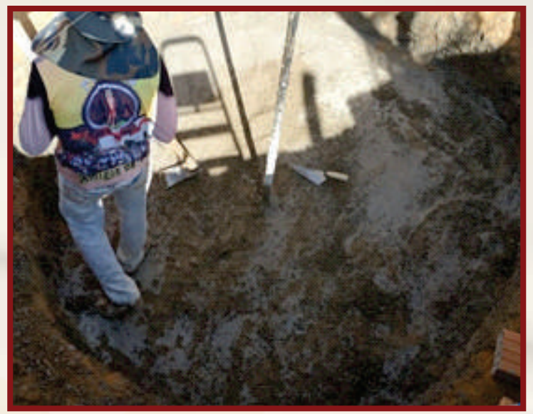
Figura 17- cano de ferro de 40 mm fixado no centro do buraco
