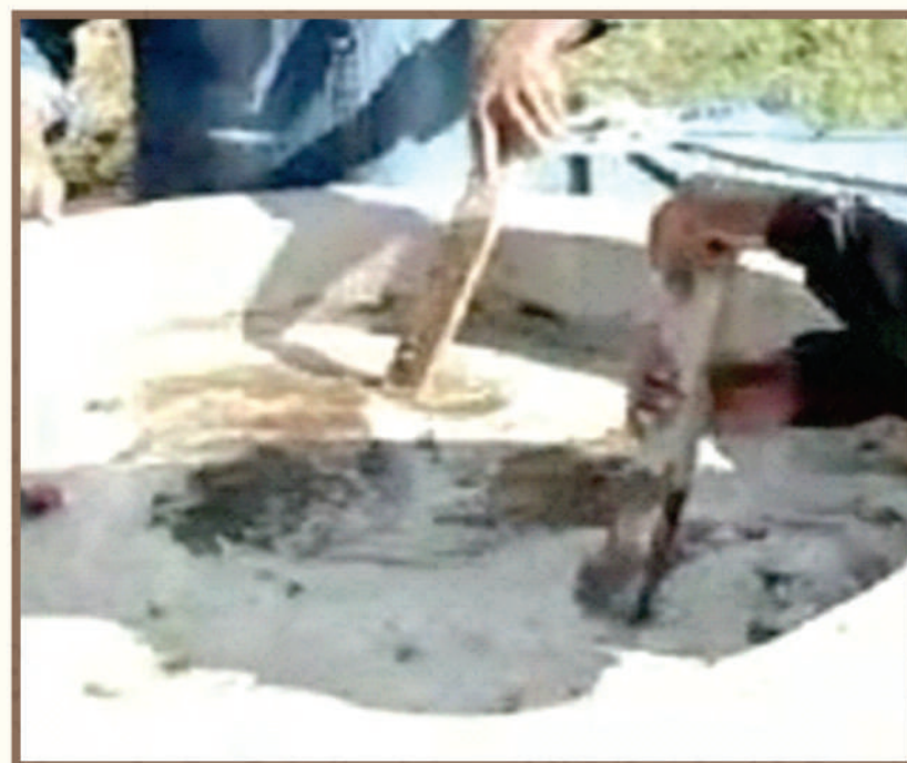
Figura 32 - Preparação do esterco com a água na caixa de entrada do biodigestor
