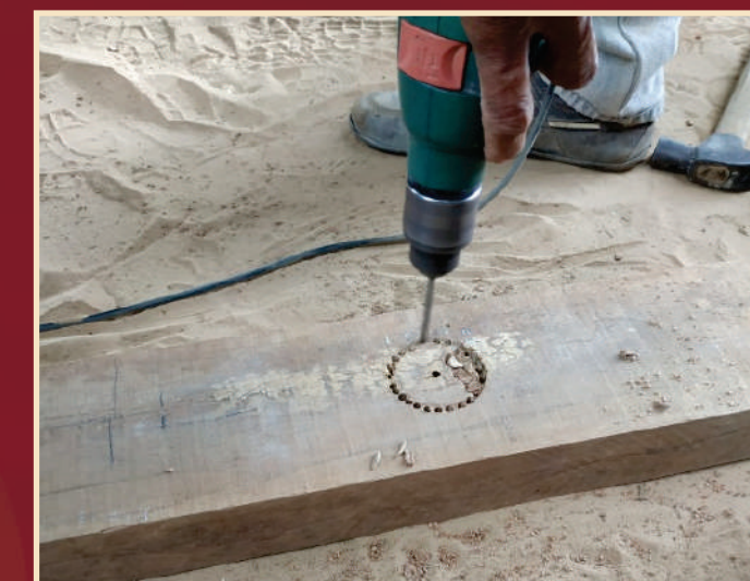
Figura 21 - abertura do furo na madeira
