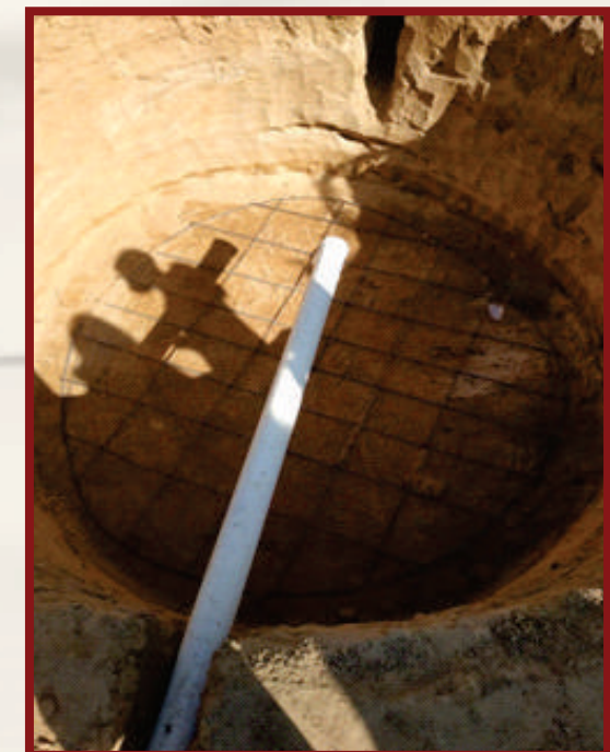
Figura 16 - grade de vergalhão de 6 mm de diâmetro
