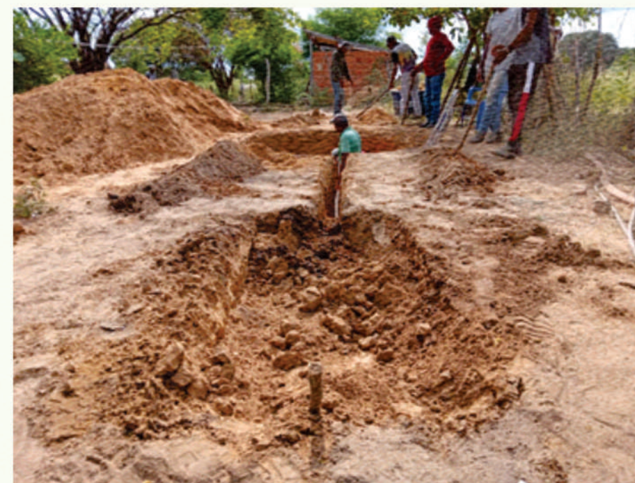
Figura 10 - Abertura do buraco para a construção do tanque de fermentação.
