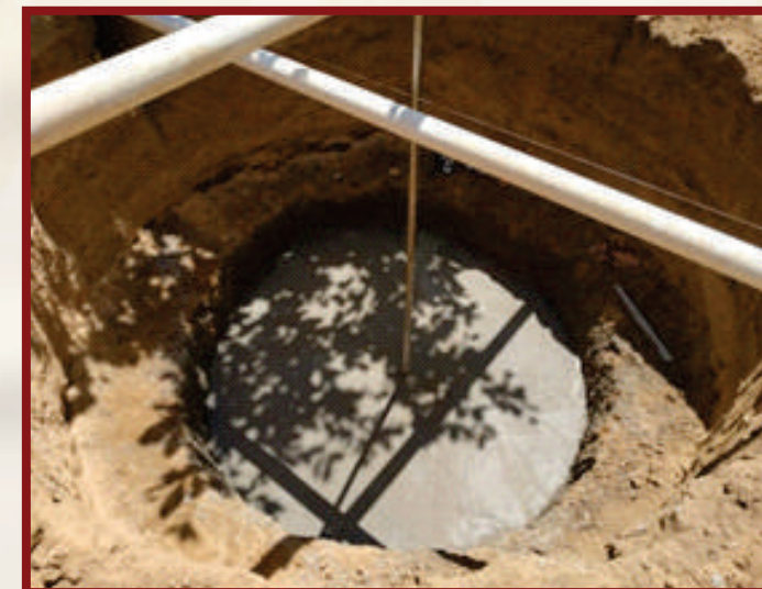
Figura 18- reforço no concreto do fundo do buraco
