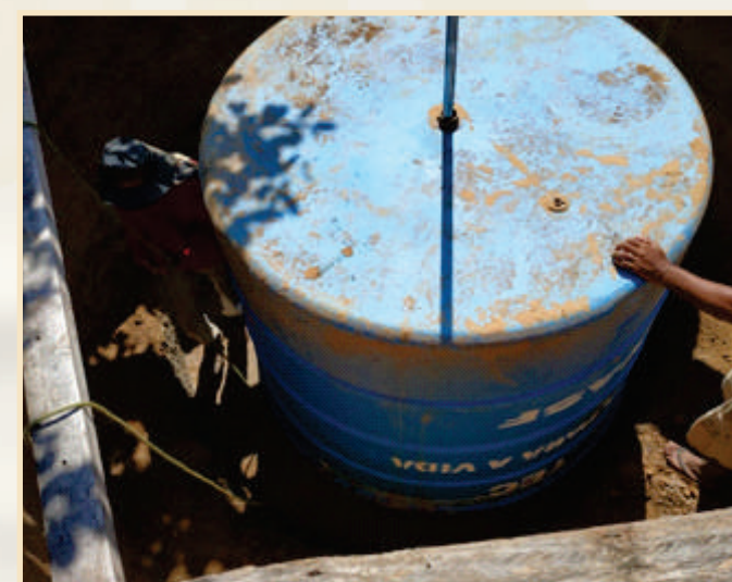
Figura 22 - Cano de 75 mm fixado na madeira e no fundo da caixa
