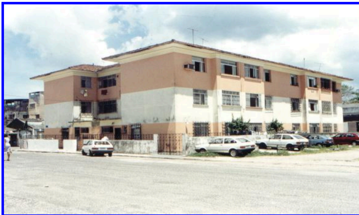
Foto 2- Detalhe de um dos blocos do Núcleo Residencial Castro Alves. Extraído de: SOUZA, 2001.
